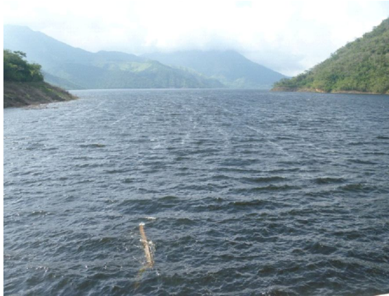
Foto No 1. Presa el Cercado
