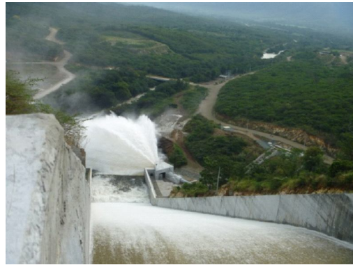
Foto No 8. Canal de descarga y deflector, flujo de 23 m 3 /s 11-12-2010
