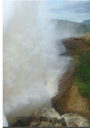
Foto No 12. Laderas de la zona de descarga de la válvula Howell Bunger
