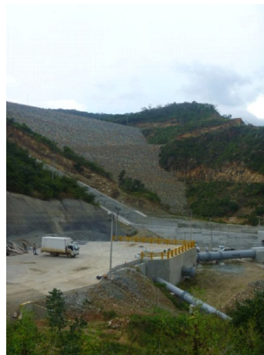
Foto No 4. Cara de enrocado presa
