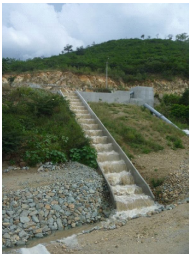
Foto No 3. Tanque de toma Conducción San Juan.
