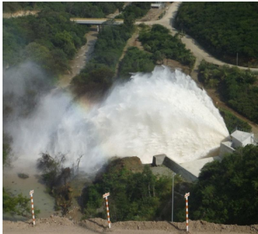
Foto No 9. Descarga de la válvula Howell Bunger
