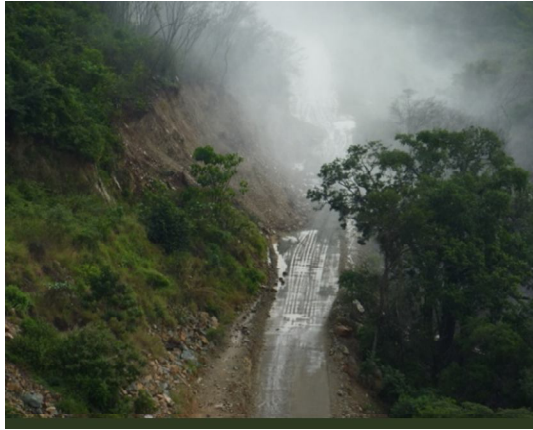
Foto No 11. Laderas de la zona de descarga de la válvula Howell Bunger.
