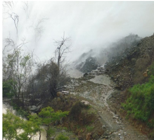
Foto No 10. Zona de descarga de la válvula Howell Bunger.
