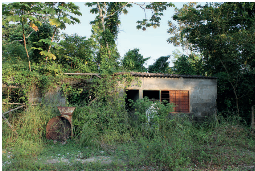
Instalaciones abandonadas de Corpoyuca. Kilómetro 60, La Gabarra, 2012. Fotógrafa: © Yamile Salinas Abdala para el CNMH.
