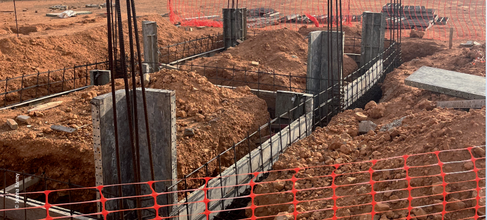
Foto 8. Cimientos construidos para casas Wayuu.
